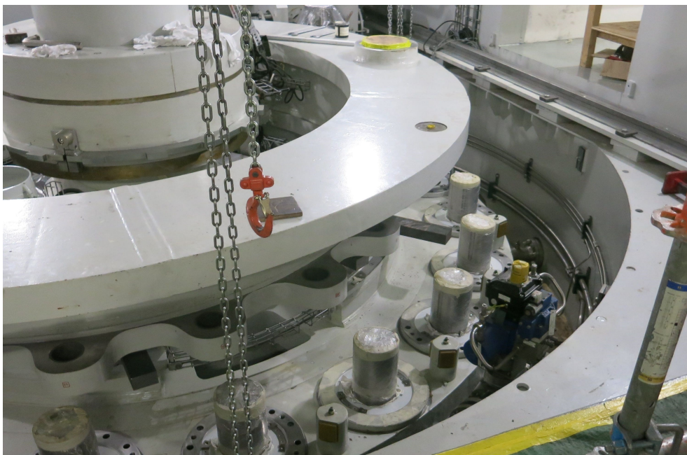
Travaux sur le distributeur
