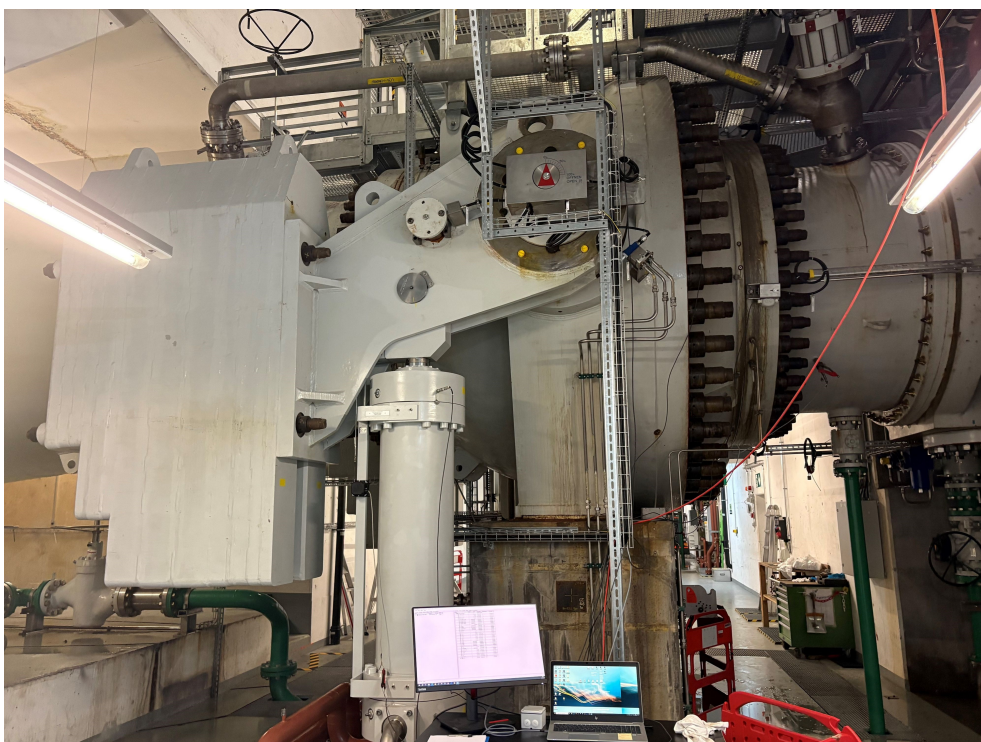
Démontage du servo-moteur de la vanne haute pression MIV
