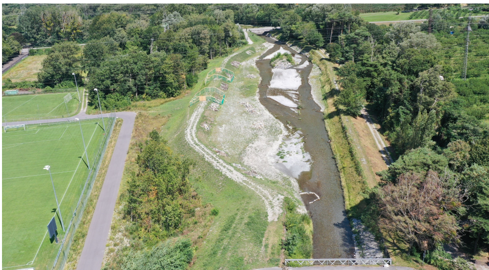
Réaménagement du Trient – Amont des Clous, état au 25.08.2025
