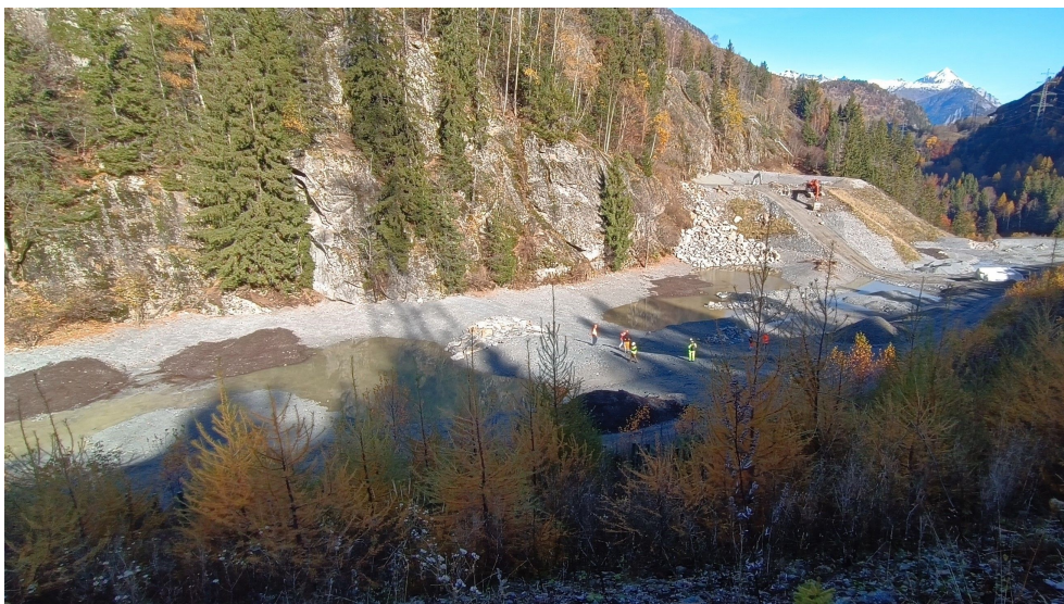
Réaménagement du vallon de Châtelard, état au 01.11.2025
